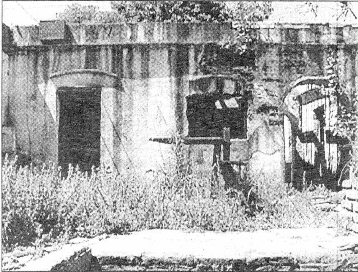
Figura 2. Estado actual de la casa
