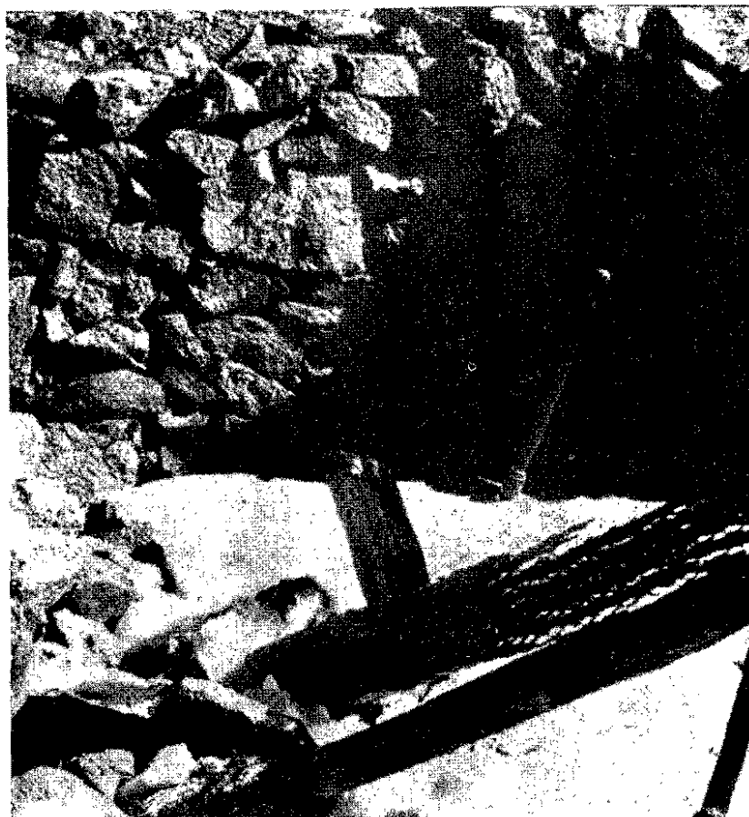
FIG. 11. — Detalle de la habitación, con las maderas del techo caídas.
