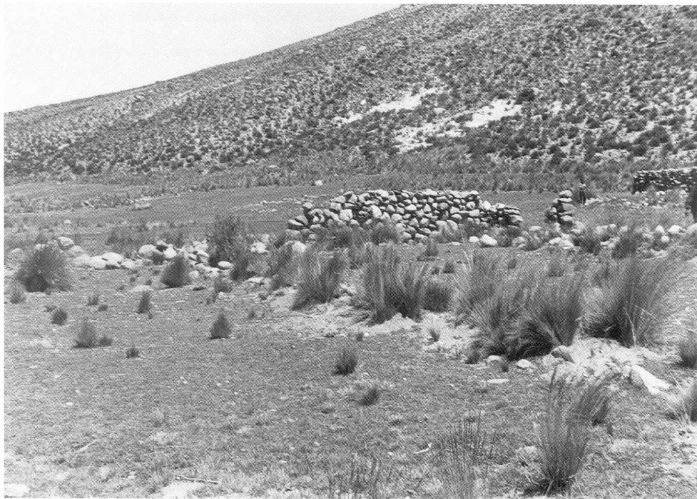
Figura 5. Tambo Alto Cajón, interior de la Kallanka (hacia la derecha) y el patio adosado (a la izquierda).
