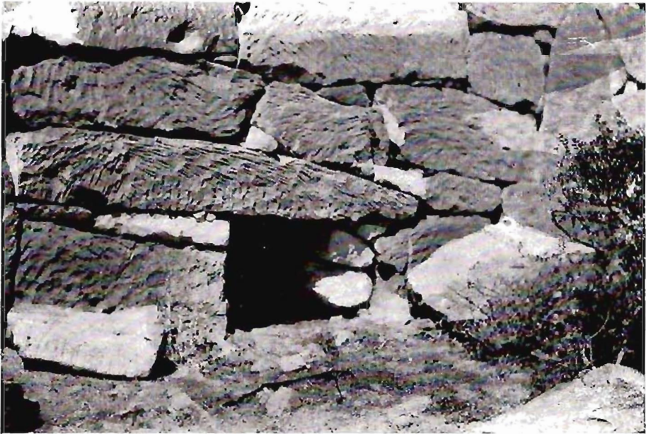
Vista de una de las bóvedas murarias.
