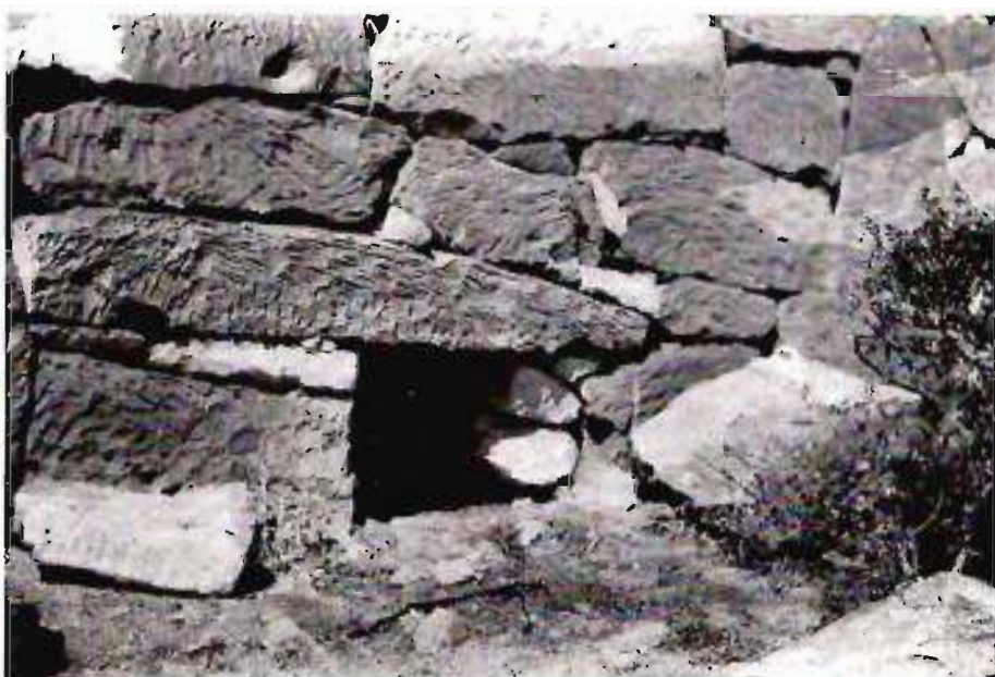
Vista de una de las bóvedas murarias.
