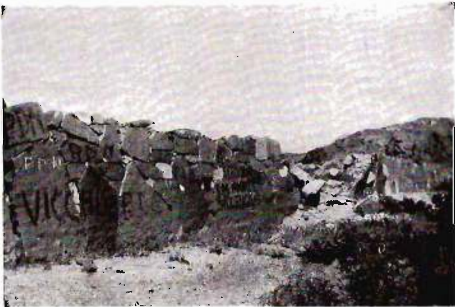
Vista externa de la muralla norte del gran rectángulo o grupo A.
