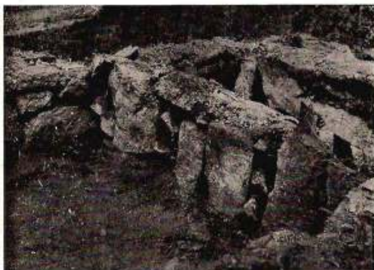
En la construcción de algunas viviendas se han empleado grandes piedras cuyas bases están profundamente enterradas.
